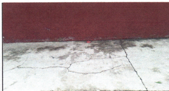
Foto 5: Módulo 4, torta de concreto en pésimas condiciones
